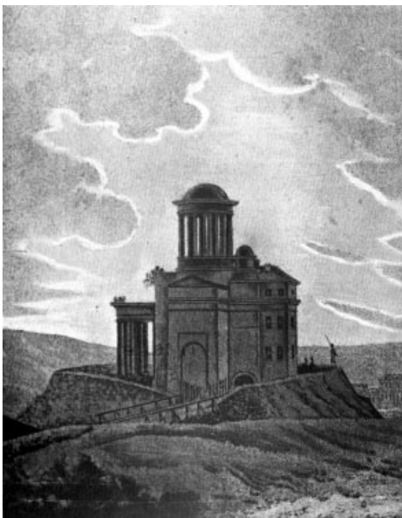
Figura 1: El edificio Villanueva convertido en un polvorín por las tropas francesas a principios del siglo XIX.
